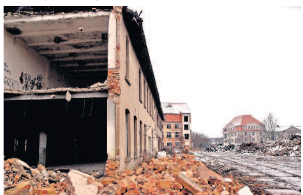
Im Frühjahr wurde mit den Abrissarbeiten begonnen. Die Arbeiten befinden sich laut dem Landkreis Bautzen aktuell voll im Zeitplan.
