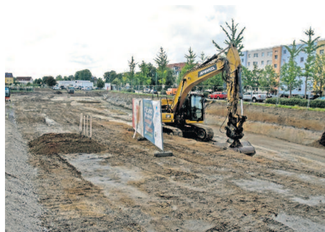
Die Tiefbauarbeiten sind bereits in vollem Gange. Nachdem weitere Erdschichten abgetragen sind, wird zunächst die Tiefgarage der Wohnanlage entstehen.
