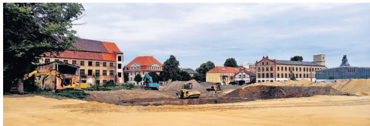
Aktuell werden die Verfüllarbeiten auf dem Areal des alten Eschebach-Geländes, welches der Landkreis für den Schulneubau erworben hat, realisiert.
